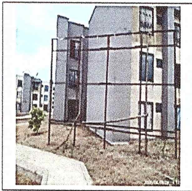
SIN NOVEDAD EN LA INSTALACIÓN DE LA PANCARTA DE INFORMACIÓN DEL PROYECTO
