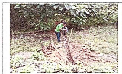
EXCAVACION DE ZANJAS PARA INSTALACION DE TUBERIA DE DESAGUE AGUA LLUVIA
