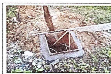
FUNDIDA CON CONCRETO 3200 PSI PARA CONFORMACION CASEZOTE PARA DESAGUE AGUAS LLUVIAS A CAÑO
