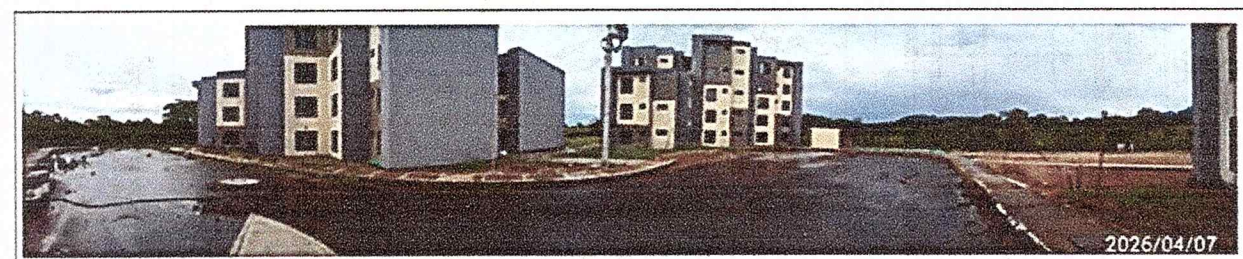
VISTA PANORAMICA ESTADO CLIMA LLUVIOSO EN HORAS DE LA TARDE DEL DIA DE HOY, COSTADO IZQUIERDO FACHADA PRINCIPAL-LATERAL TORRE 5 - VISTA FRONTAL VIA INTERNA 2 CON ENCHANCAMIENTOS DE AGUA LLUVIA SOBRE LA CAPA SUPERIOR DE LA ASFALTITA - COSTADO DERECHO FACHADA FRONTAL TORRE 3
