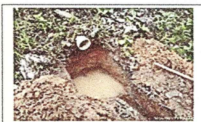
EXCAVACION PARA CONSTRUCCION DE CASEZOTE PARA DESAGUE DE AGUAS LLUVIAS SOBRE FACHADA LATERAL IZQUIERDO TORRE 5
