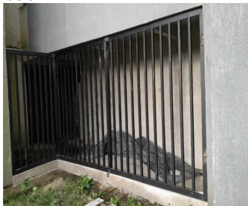
Imagen No.13 Instalación Ornamentación de puertas de acceso a las torres 3 y 5
