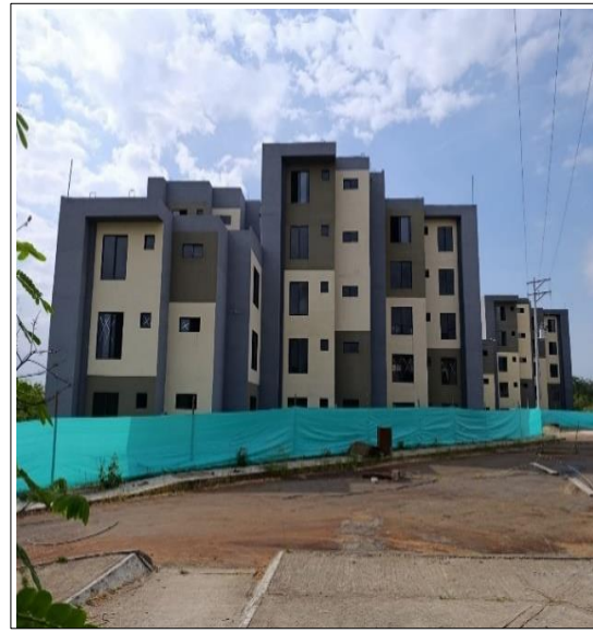
Imagen No.2 Fachada trasera torre 3 avance 99%
