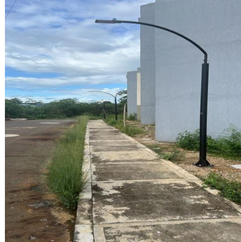
Imagen No.9 Instalación Potería y luminarias exteriores.
