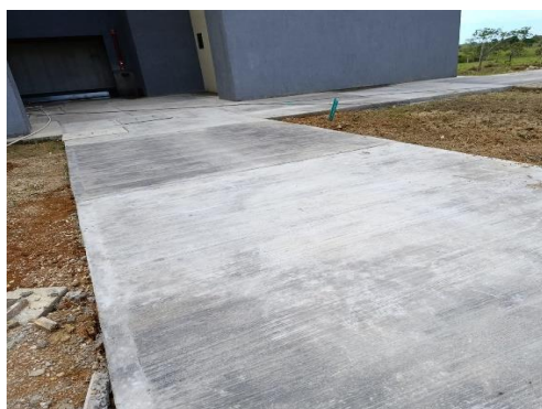
Imagen No.14 Fundición placas de acceso a las torres 3 y 5.
