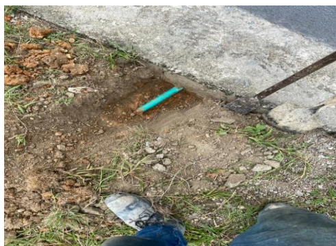
Imagen No.17 Instalación red eléctrica y luminarias urbanas
