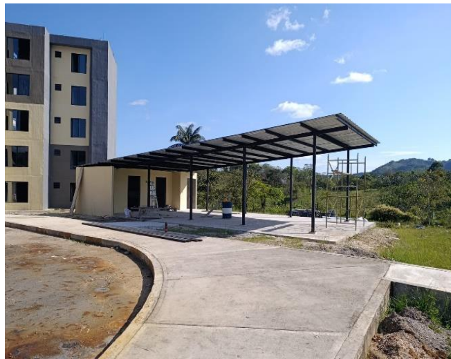
Imagen No.3 Construcción salón social, placa entrepiso, levante muro, columnas metálicas para estructura, Cubierta, componente hidrosanitario, eléctrica obra gris y acabados avance 99%.
