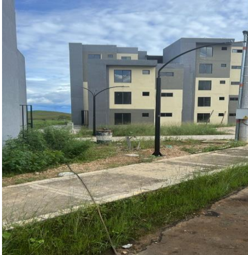
Imagen No.8 Instalación Potería y luminarias exteriores.
