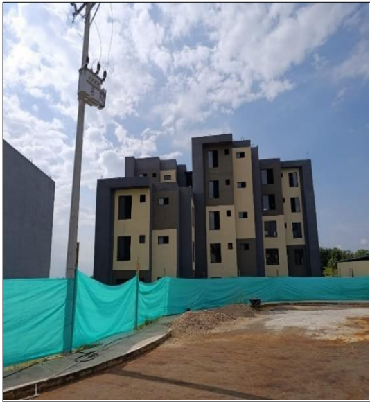
Imagen No.1 Fachada trasera torre 5 avance 98%
