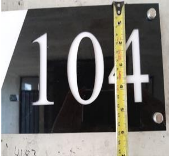
Imagen No.4 Instalación de señalización.
