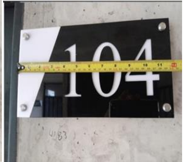
Imagen No.5 Instalación de señalización.
