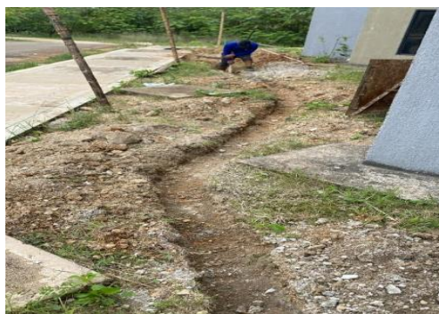
Imagen No.16 Instalación red eléctrica y luminarias urbanas
